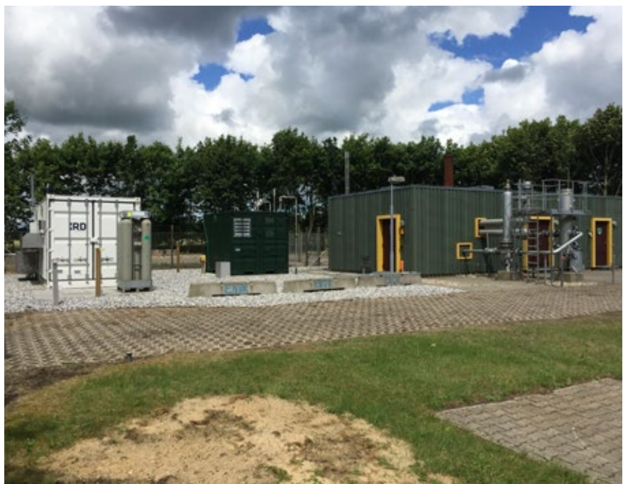
Billede fra anlægget, hvor følgende dele kan ses: Elektrolytator er i den hvide container til venstre på billedet, den mørkegrønne i midten er kompressoren, og bygningen med med gule dørkarme er MR-Helle.
